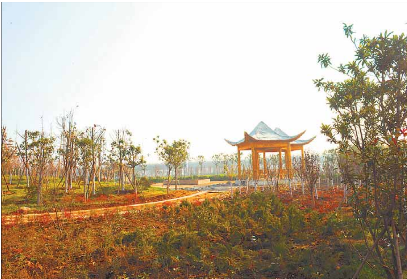
集休闲、生态、娱乐、健身于一体的南海公园项目工程目前已进入收尾阶段。该项目位于市城乡一体化示范区南海路与泰山路交汇处,总规划面积约4.34万平方米。
