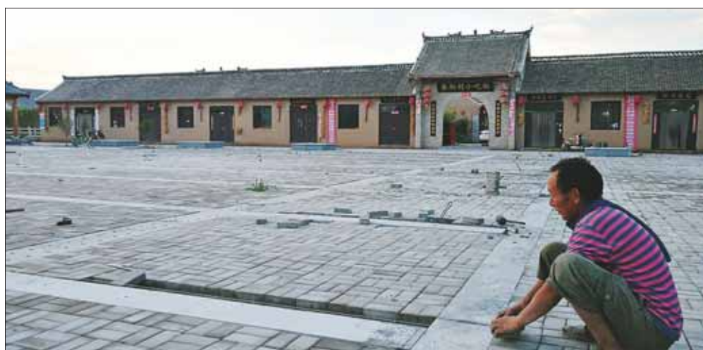
工人在铺设秦街小吃街门前广场地砖。
