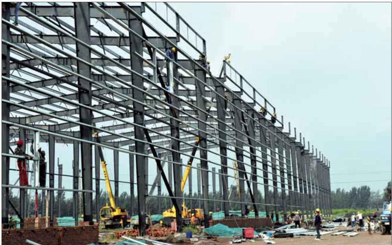
位于玖洲国际电商物流产业园项目总投资6.5亿元，主要建设电商总部基地、农产品展销中心、中原农贸城、智能仓储中心、物流信息交易中心、冷链物流中心、电商孵化与培训中心等。图为近日拍摄的正在建设中的智能仓储中心项目，该中心预计9月底建成并投入使用。
