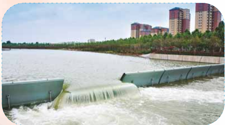
泰山路北側液坝正在放水。
