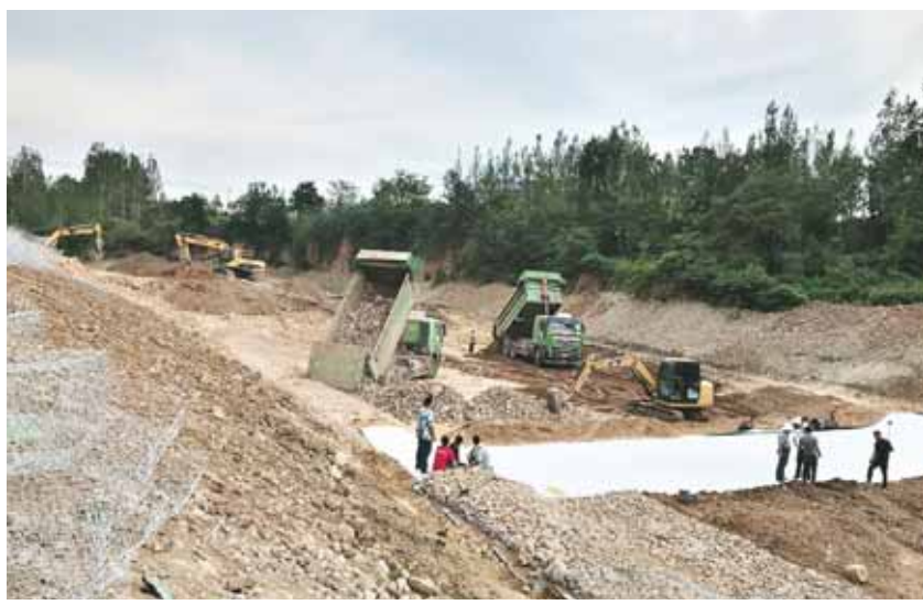
图为泗河河道生态修复整治项目现场。
