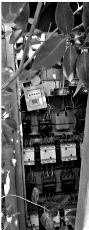
1月18日，记者在淇滨区兴鹤大街与九州路交叉口发现，隐藏在绿化带树丛中的变压器外壳裂开，里面的电子元件裸露在外。如果遇到下雨天，雨水进入变压器的电子元件中，就会很危险，希望有关部门及时予以解决。
