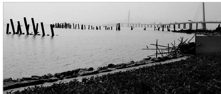
深圳湾南北观海栈桥工程现场。
