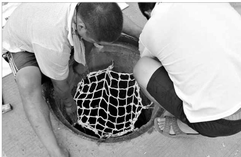
施工人员正在加装窨井防护网。
