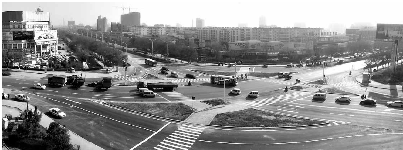
大转盘拆除后,107国道与淇滨大道交叉口改造为十字路口,车辆通行更加有序。 晨报记者 赵永强 摄
