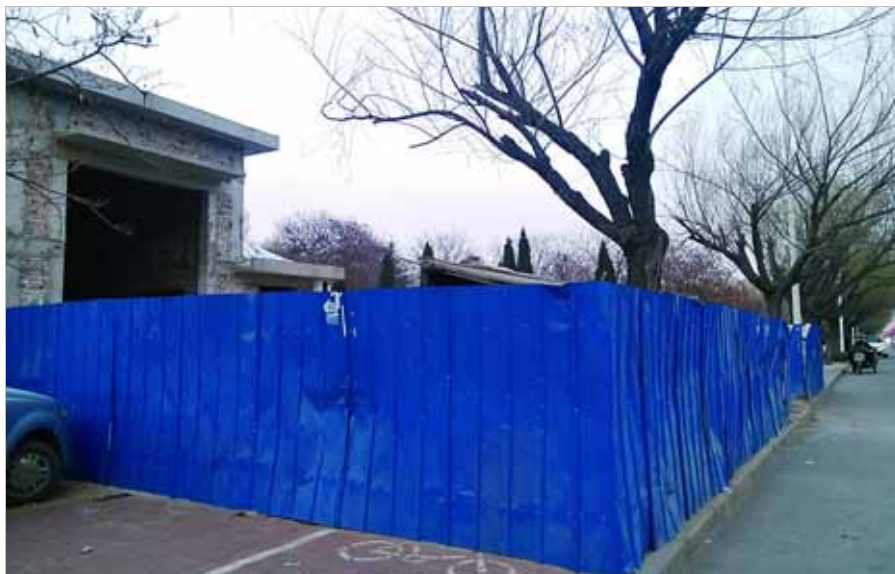
施工围墙堵在人行道上 百姓热线记者 马龙歌 摄
