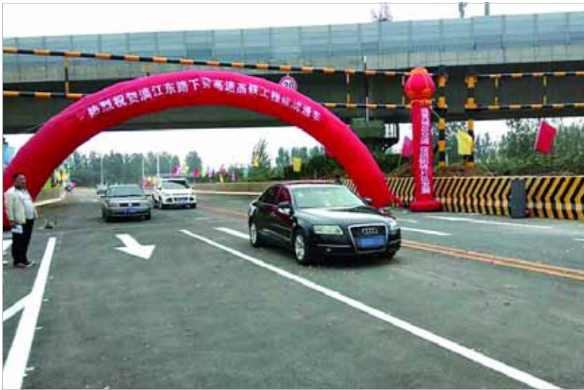
漓江东路下穿高速高铁工程建成通车
