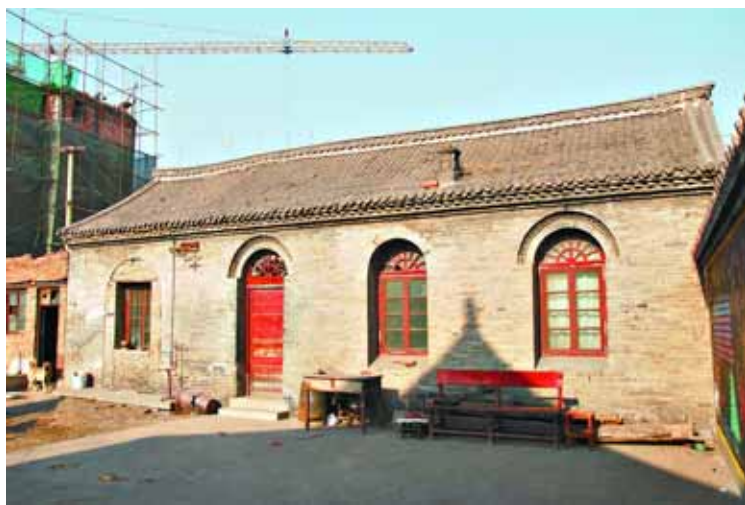
天主教堂的神父楼,第一层已经下沉。 赵永强摄于2009年12月22日
