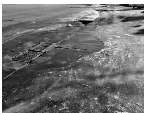
污水井溢出约一公里“冰河”
