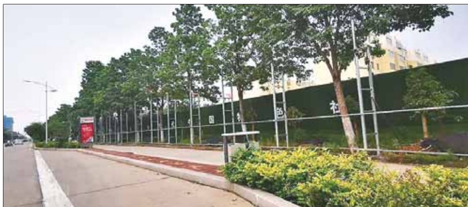
公交候车亭拆除后等待重建。晨报记者 岳珂 摄
