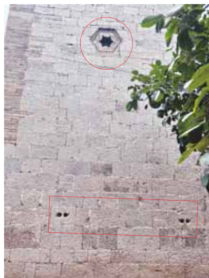
炮楼外牆上面有射击孔,下面有拴马洞
