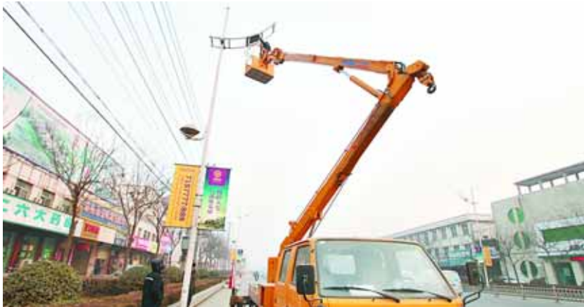
为保证城区居民夜间安全出行,连日来淇县供电公司对全县3000多盏路灯进行维护检修。图为1月5日该公司员工在107国道维护路灯。 左华军 摄
