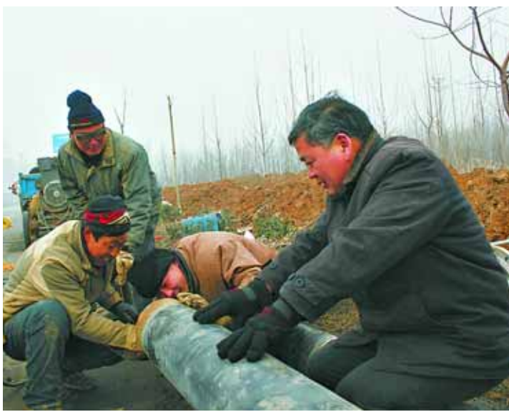
1月29日,石林工业集聚区天然气集中供气项目二期工程在加紧施工。据悉,该项目由河南天伦新能源有限公司投资建设,目前一期已建成通气,二期3公里燃气管网正在铺设。彭戴 王欢 摄
