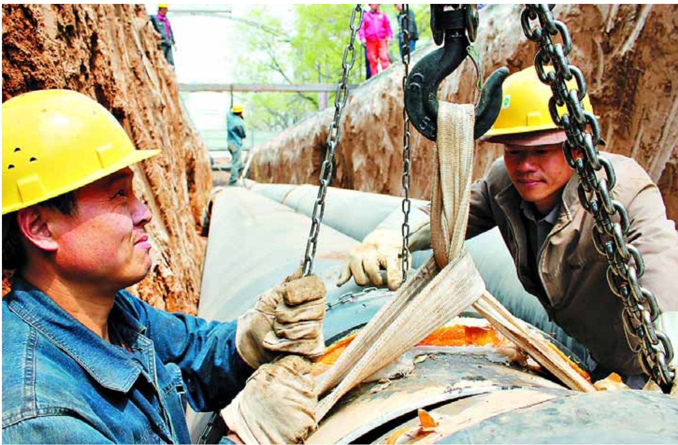
4月17日，工作人员正在山城区春雷路安装供热主管道。据了解，山城区集中供热项目总投资5亿元，目前已完成投资2亿元，铺设管网5公里，建换热站1座。
