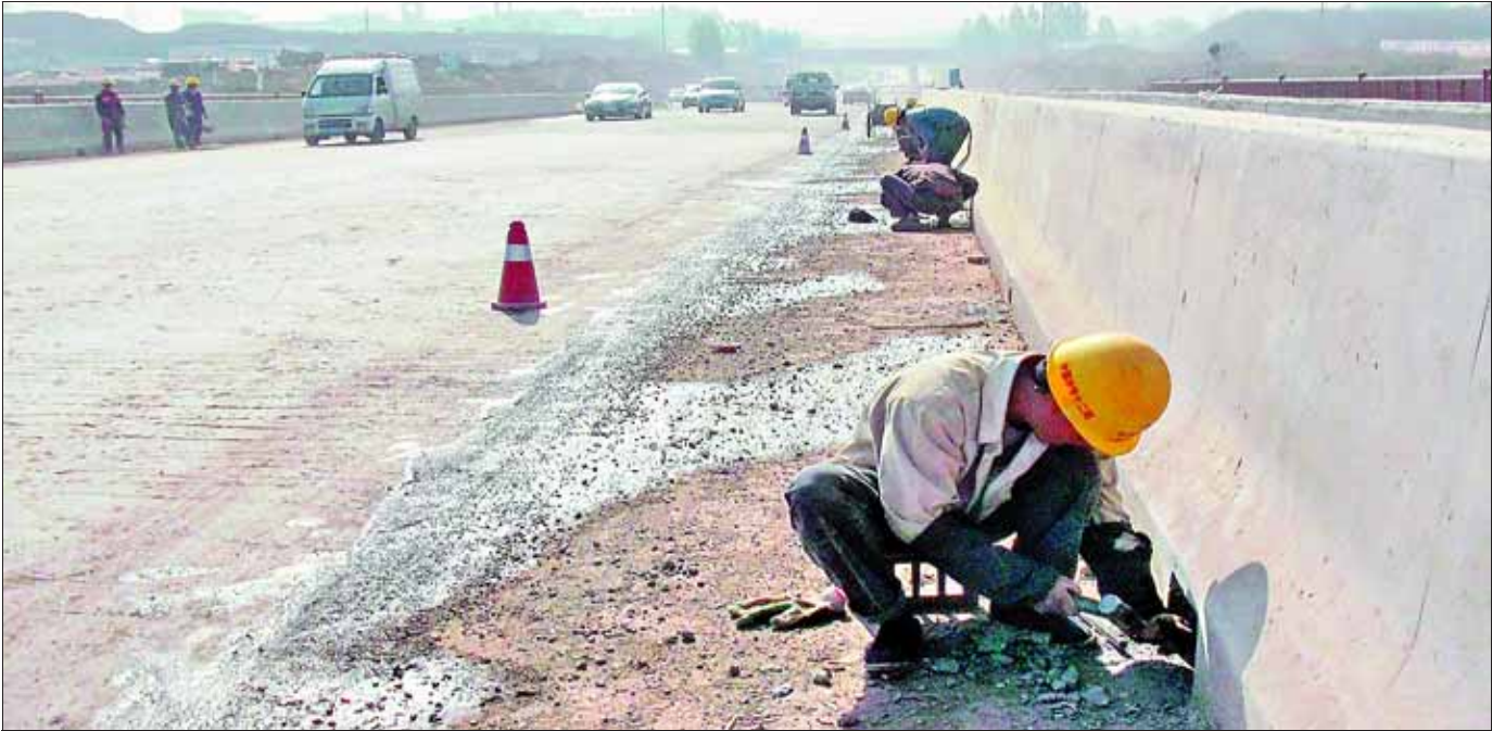
5月1日，工人们在新老区快速通道的公路桥上安装排水设施。为确保按计划完成国家重点建设项目的进度，南水北调中线工程鹤壁段的建设者放弃“五一”假期，坚守在工地上。 本报记者 李国庆 摄
