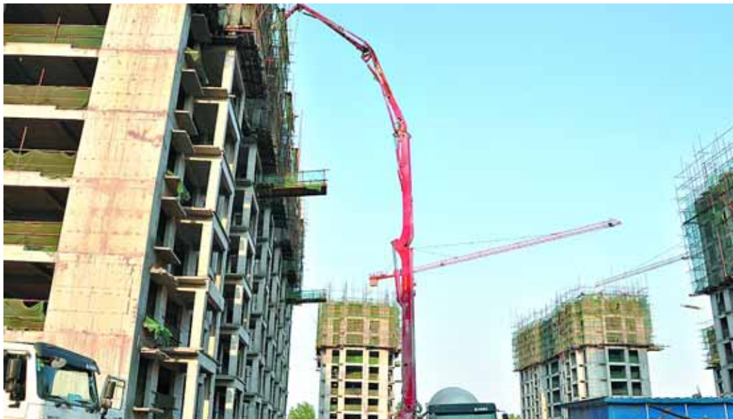
4月25日,正在建设中的淇园社区项目。该项目位于淇县高村镇,总投资6.65亿元,总建筑面积36.8万平方米,建成后可安置群众5800余人,节约土地2308亩。
