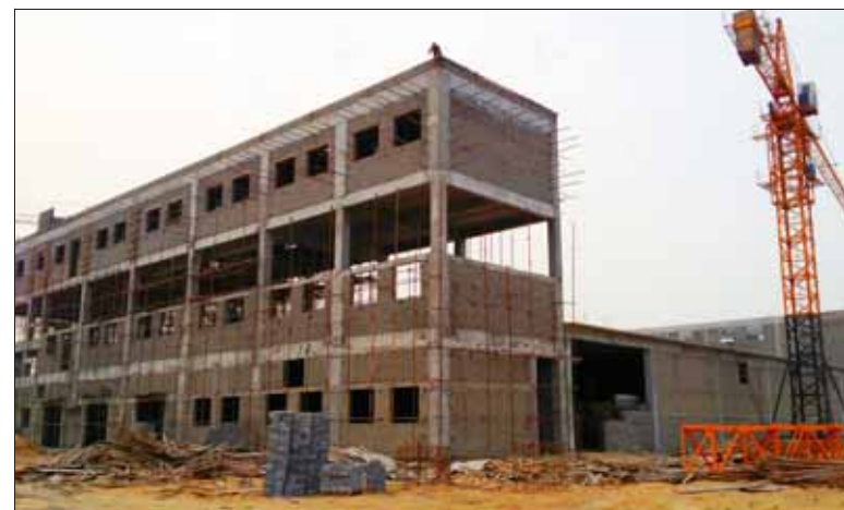
位于浚县粮食精深加工园区的中鹤制麦有限公司年产5万吨麦芽及饮品项目,总投资1.9亿元,于去年10月开工建设。截至目前,项目的两栋生产车间已经基本建成,两栋仓库也即将封顶。一期年产5万吨麦芽项目计划今年10月底投产。“现在设备已经订购,一周左右就能进厂安装。”5月6日,项目负责人李刚说。图为正在建设的生产车间。本报记者 张心致 郝爽 摄
