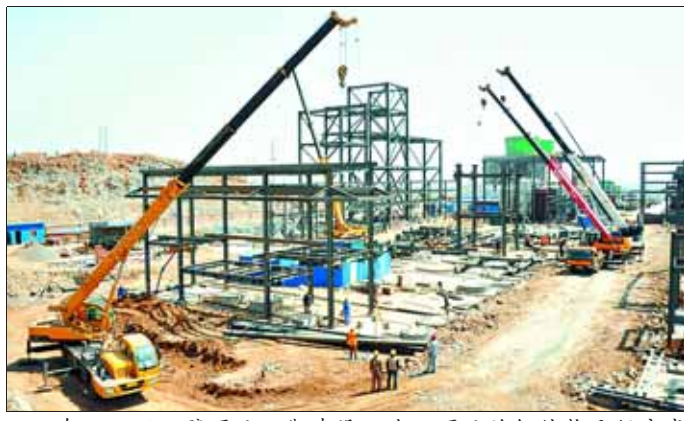
在1,4-丁二醇项目二期建设工地,项目的钢结构已经完成60%,钢筋混凝土铺设也基本完成,设备已于4月初开始安装。6个交换器装置基本安装到位(摄于4月25日)。
