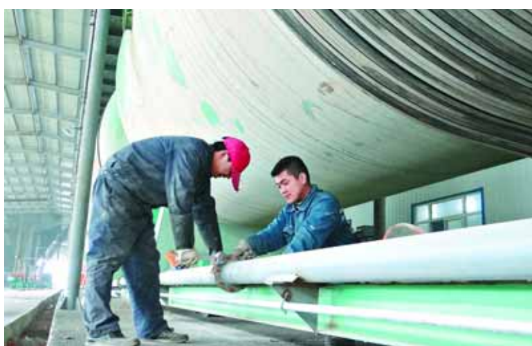
华都精细陶瓷有限公司总投资2亿元,建设4条等静压微晶中高铝瓷球、铝衬砖生产线。目前,该项目一期工程建设的窑炉生产线、磨机及其配套设施已安装完毕,进入紧张调试阶段。图为安装人员进行调试(资料图片)。
