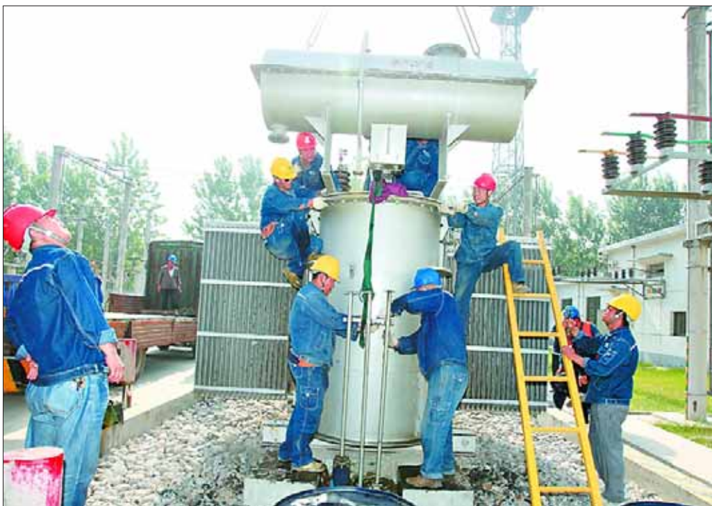
5月21日,淇县供电公司组织员工对35千伏朝歌变电站和庙口变电站主变进行更换,以满足迎峰度夏期间用电负荷增长需求,让老百姓放心用电。
