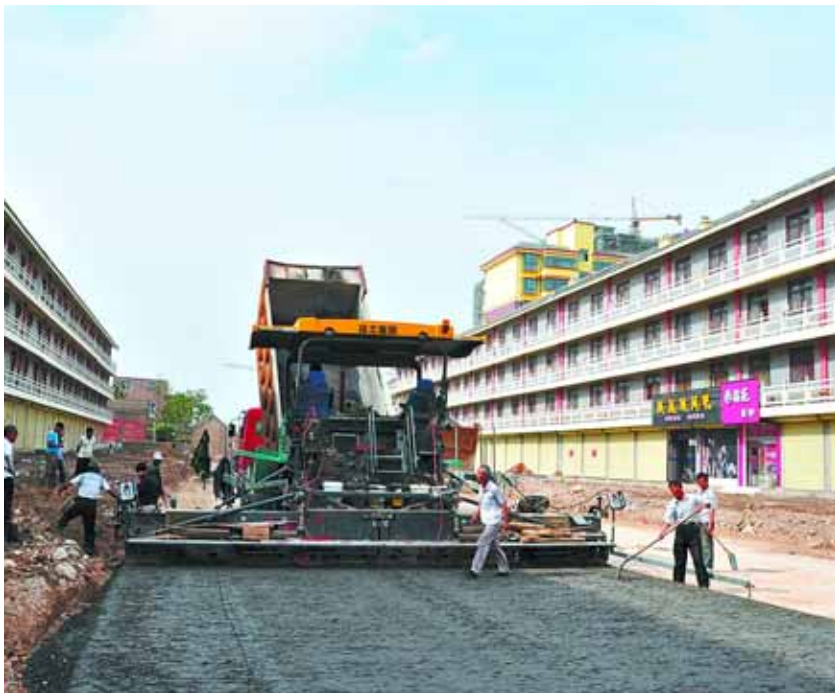
今年以来,淇县加大旧城区道路建设力度,完善城区功能,投资1000余万元修建了中山路北段、淇园路北段两条市政道路。图为5月30日在施工的中山路北段工程。 中民 海洋 摄
