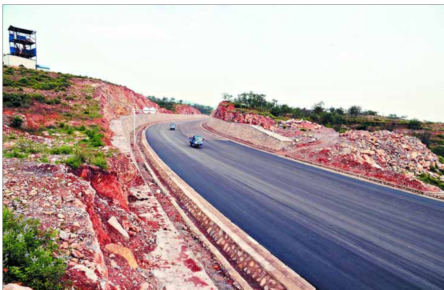
快速通道北延二期工程通车。
