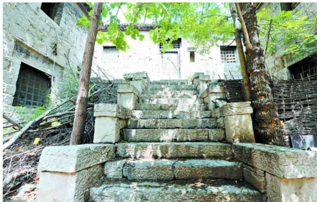
“九门相照”中的第九个堂屋门距院子地面约3米高。
