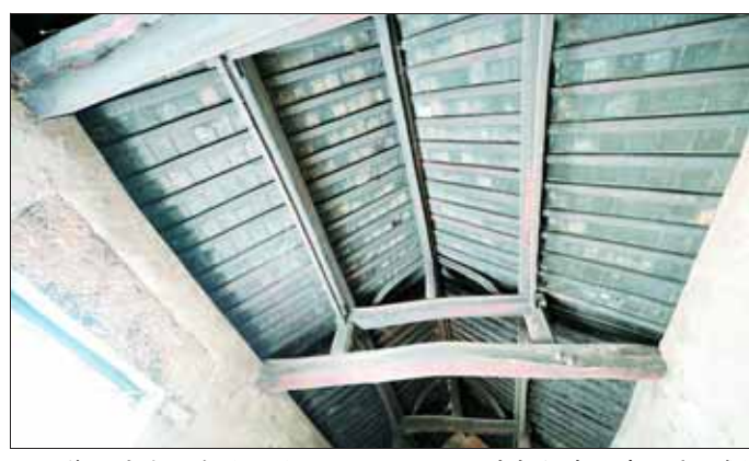
第二座庭院堂屋的屋顶。 本报记者 李国庆 摄
