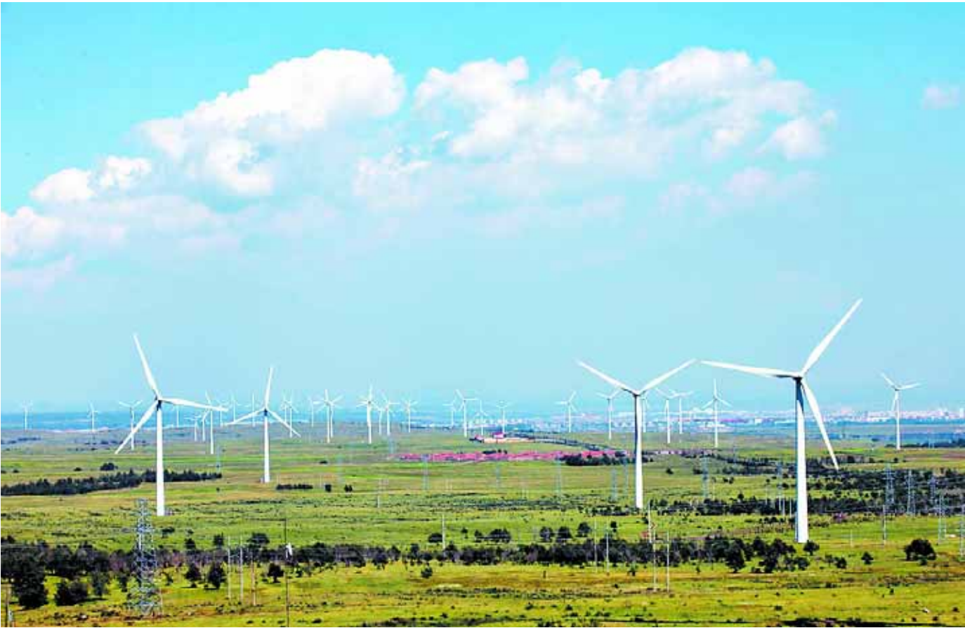
河北张家口地区风资源储量达2000万千瓦以上，可开发量达1170万千瓦以上，占河北省陆上风资源的71%。从2006年开始，张家口地区风电发展进入井喷期，先后有40多个风电场落户。截至目前，接入张家口地区电网的风电装机容量达到477万千瓦。图为运行中的张家口市张北县中节能风电场（8月21日摄）。
