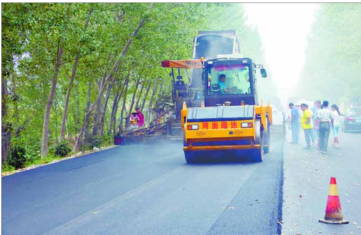
今年以来,浚县积极争取上级项目资金,加快公路升级改造步伐,有效改善了境内交通环境。图为8月28日永定线小河段改造项目建设施工现场。
