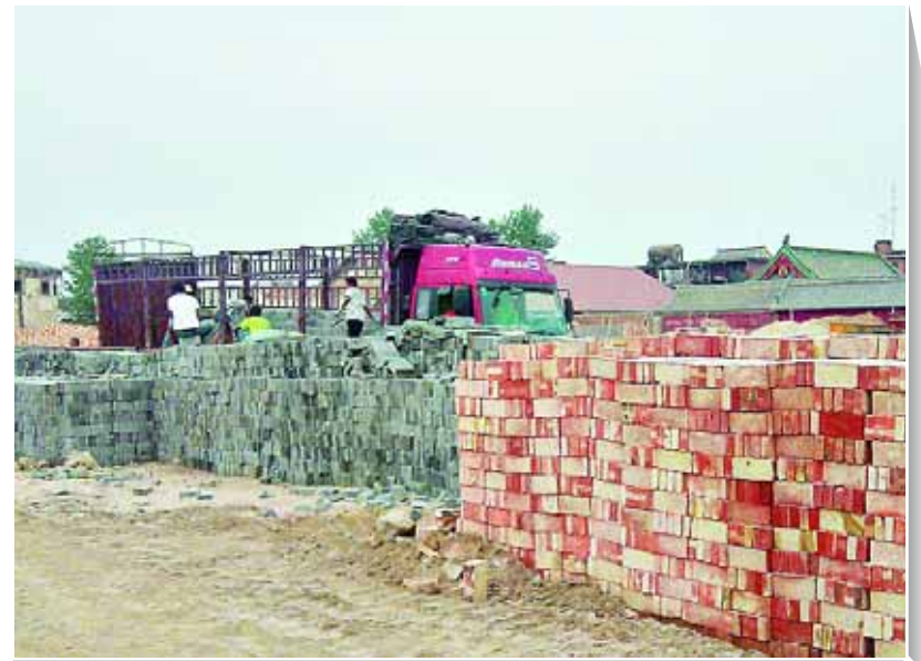
重建古县衙的工地上,工人们正在搬运建筑材料。 尚海民 摄
