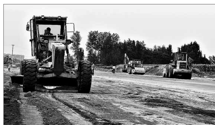
今年以来,淇滨区全面启动城区道路管网建设,新建、续建了闽江路、珠江路等城市道路38条(段)24.5公里,目前已完成9条(段)3.9公里,在建19条(段)11.1公里,近期拟开工10条(段)9.5公里。图为施工人员在华山路南段平整路基。本报记者袁国强实习生武文杰摄于9月3日
