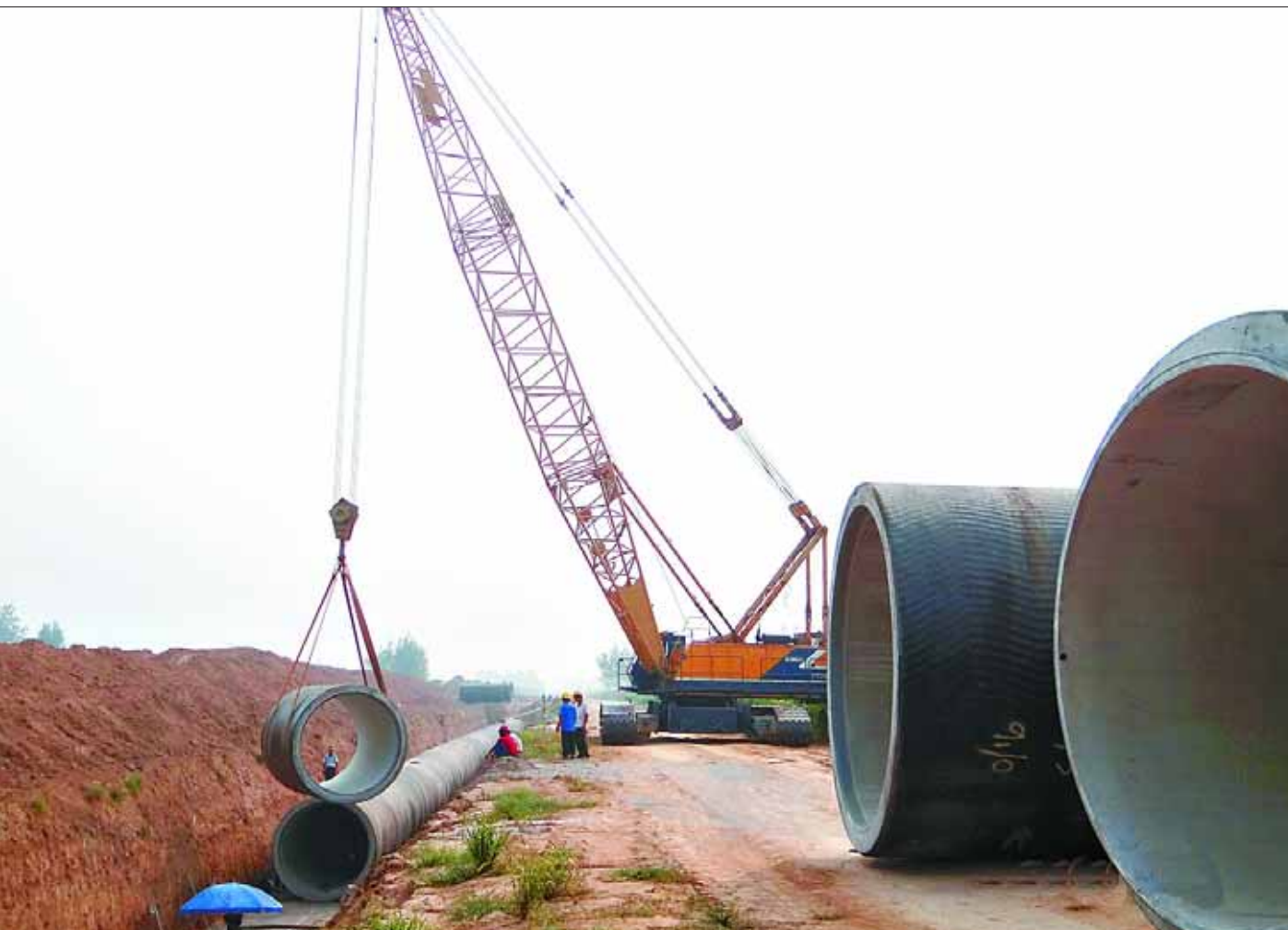
9月17日,在淇滨区钜桥镇刘寨村,工人们正向管内调运庞大的输水管道,南水北调中线鹤壁配套工程正在紧张施工。南水北调鹤壁配套工程总投资11.8亿元,工程主要由分水口门、输水管线、水厂及管网等3部分工程组成,工程自去年11月开工以来,已累计完成投资4.8亿元,管沟开挖52公里,管道铺设36.4公里
