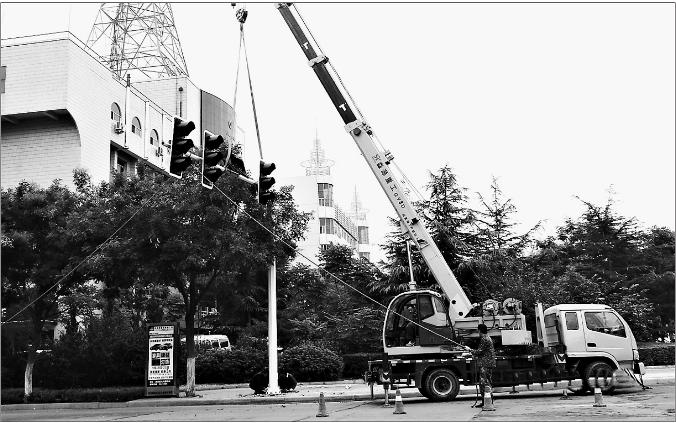
今年淇滨区对城区34个路口的交通信号灯进行改造，对130个路口增设信号灯，实现国标信号灯的全覆盖。全部路口使用联网式信号机，对每个路口都可实现后台控制，在60多个主要路口实现智能交通，可按照机动车流量自动调节红绿灯时间。图为9月22日，施工人员在淇滨区九州路与黄山路交叉口吊装新型道路交通信号灯。
