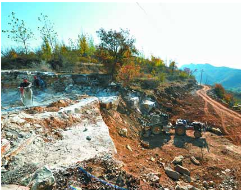
鹤山区五岩山风景区山后旅游专线工程项目目前正在紧张施工中。专线线路自施家沟村起,经孤尾沟村、张家沟村至老望岩村,建设标准为国家三级公路,全长约7公里,路基宽9米,路面宽6.5米,总投资730万元。毕燕周 张旭 摄
