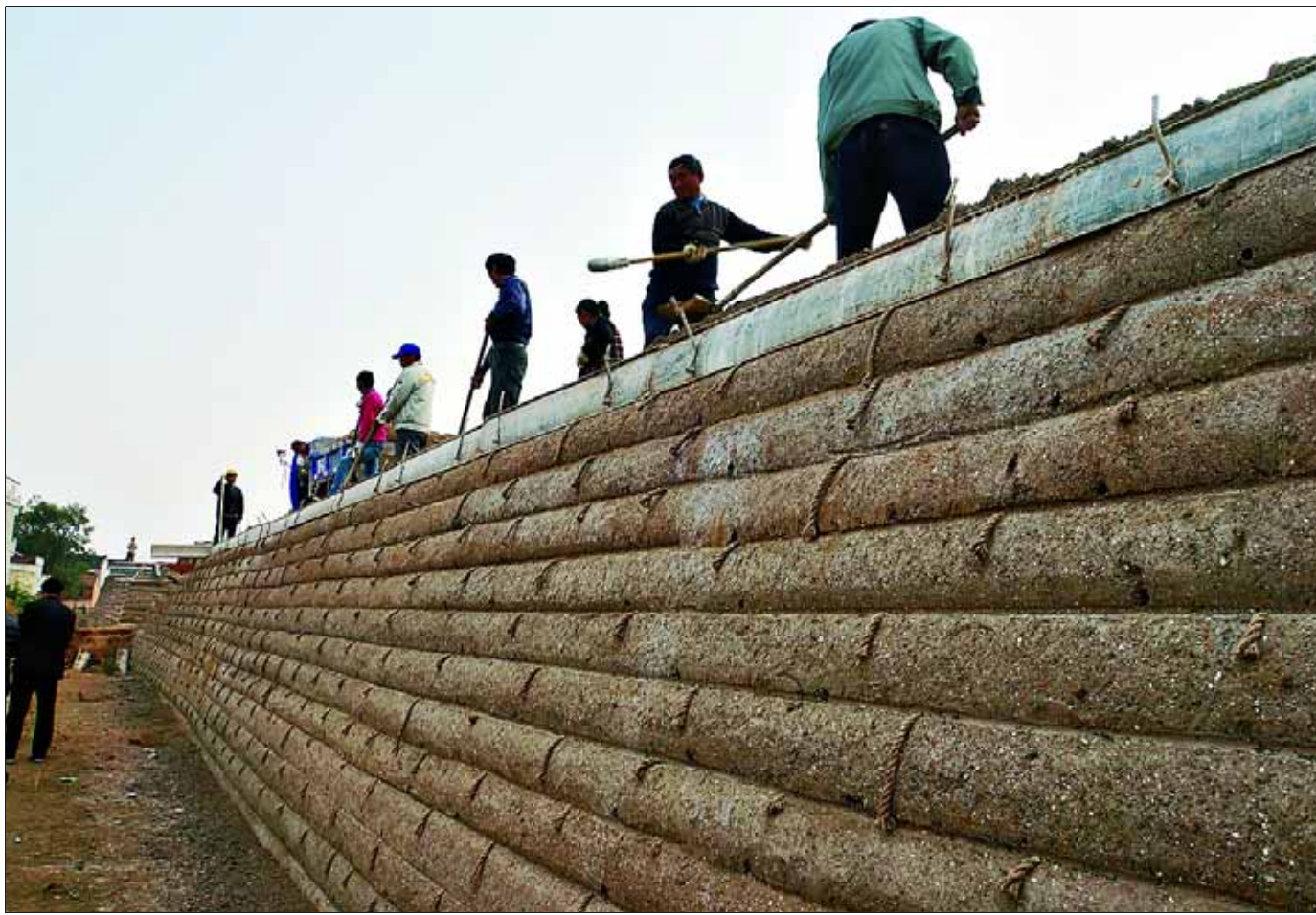
今年以来,浚县以大运河申遗为契机,遵循“留古、复古、承古、用古”的理念,启动了浚县古城墙保护修复工程。浚县古城墙是卫河(永济渠)滑县浚县段重要的运河城镇遗存,也是浚县明代古城的标志建筑,南北长768米,高5.7米,宽7米。图为正在修复的浚县古城墙。 姚岚 摄于11月10日
