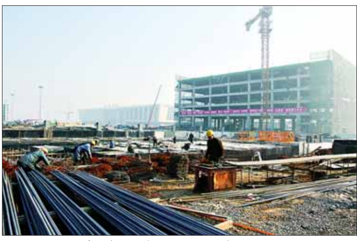
建设中的鹤壁公路运输综合客运枢纽站
