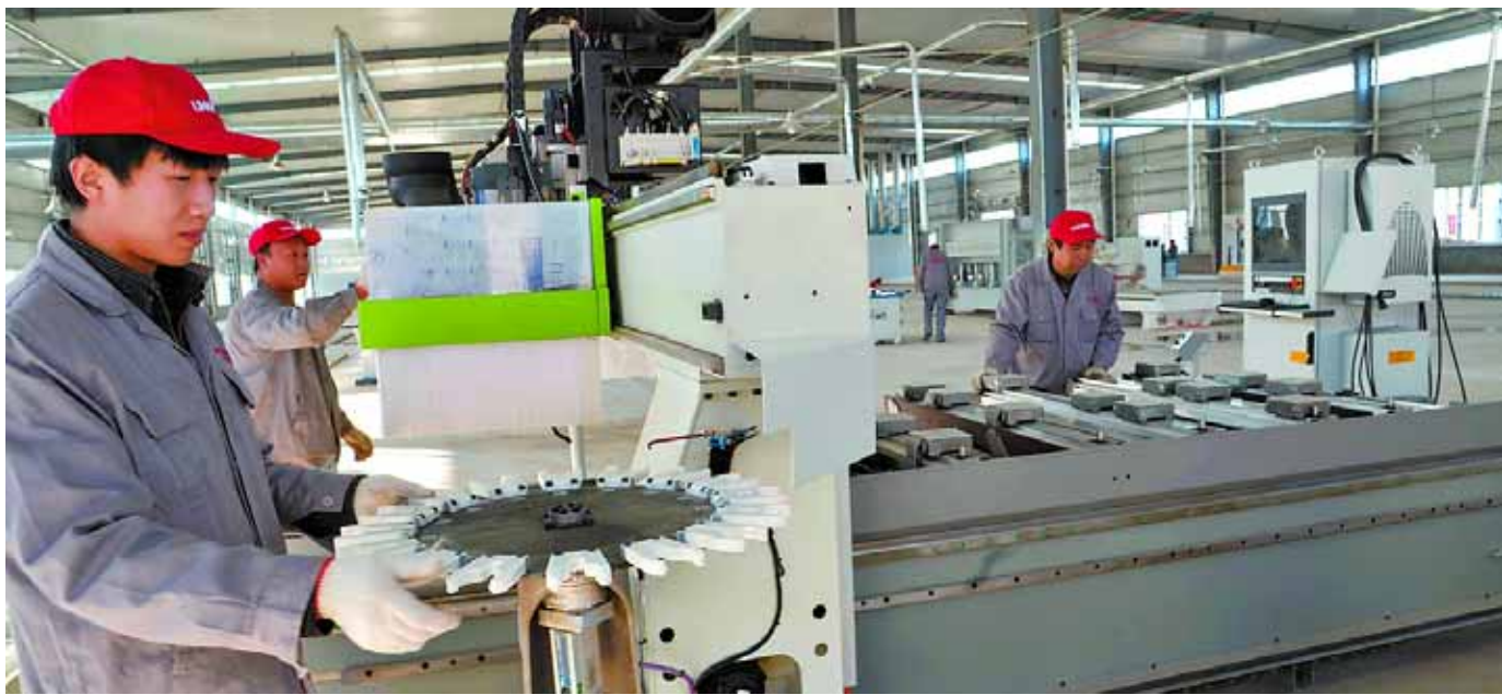
12月9日,位于浚县产业集聚区的聆海集团年产190万套整体家居项目一期生产车间内,技术人员正在安装生产设备。该项目总投资22亿元,占地700亩,其中一期投资12亿元。目前,4栋钢结构厂房、办公楼、宿舍楼主体已完工,6栋车间正在安装钢构,部分生产线正在进行设备安装。项目全部投产后,年可实现销售收入60亿元、利税2亿元,可安排7800人就业。 本报记者 李国庆 摄
