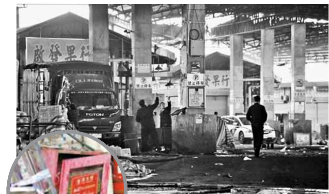
警方在检查火灾后的现场(上图) 消防栓破旧不堪(左图)
