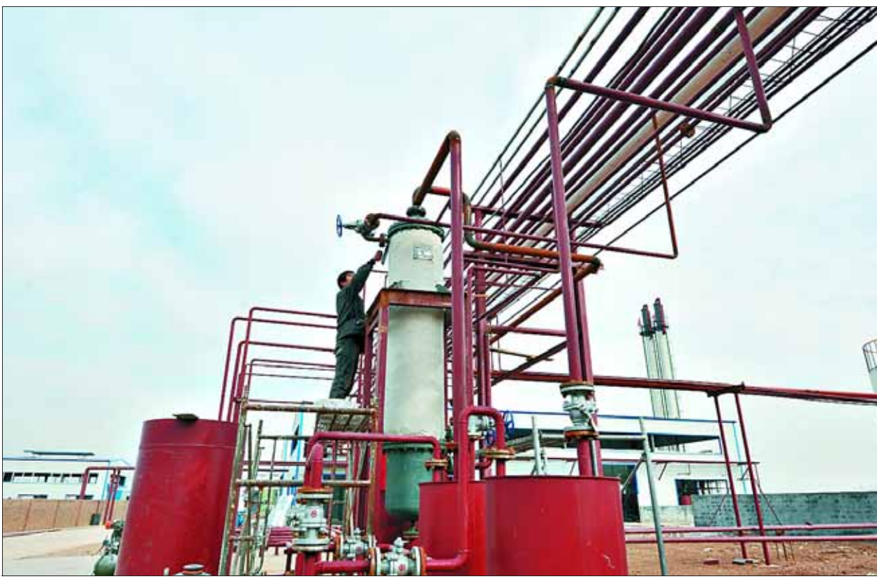
鹤山区赛科化工有限公司年产5000吨2-甲基吡啶项目压缩车间、反应车间、精馏车间、乙炔制备车间、罐区、仓库等已建成,设备已安装完毕,正在进行管道保温和电缆、电器安装。该公司生产的产品主要应用于医药、农药、化肥、胶片感光剂、染料中间体、橡胶促进剂等20多个领域,市场前景广阔。图为12月16日,工程人员正在施工。 毕燕周 摄
