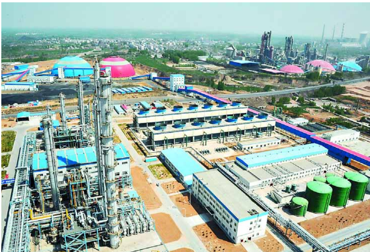
位于宝山循环经济产业集聚区内的年产60万吨甲醇项目。
