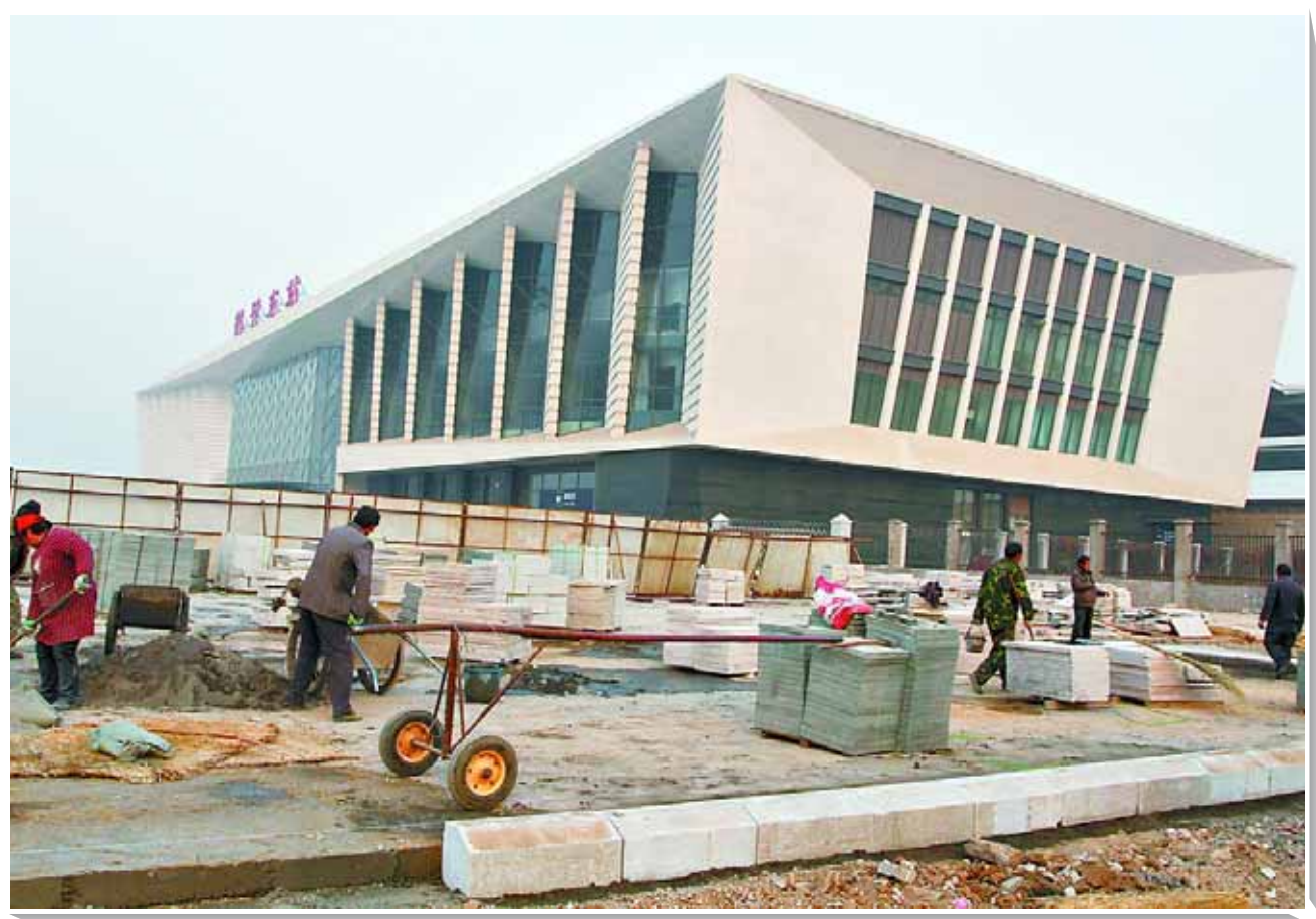
日前,淇滨区成立泰山路隧道项目推进工作组,加快泰山路隧道和高铁广场建设。目前,泰山路隧道主体全部竣工,高铁站房前70米隧道石材全部完成铺设,高铁广场已投入使用。图为1月10日,高铁东站通往贵宾室停车场的路面铺设正在施工。孙伟民 摄
