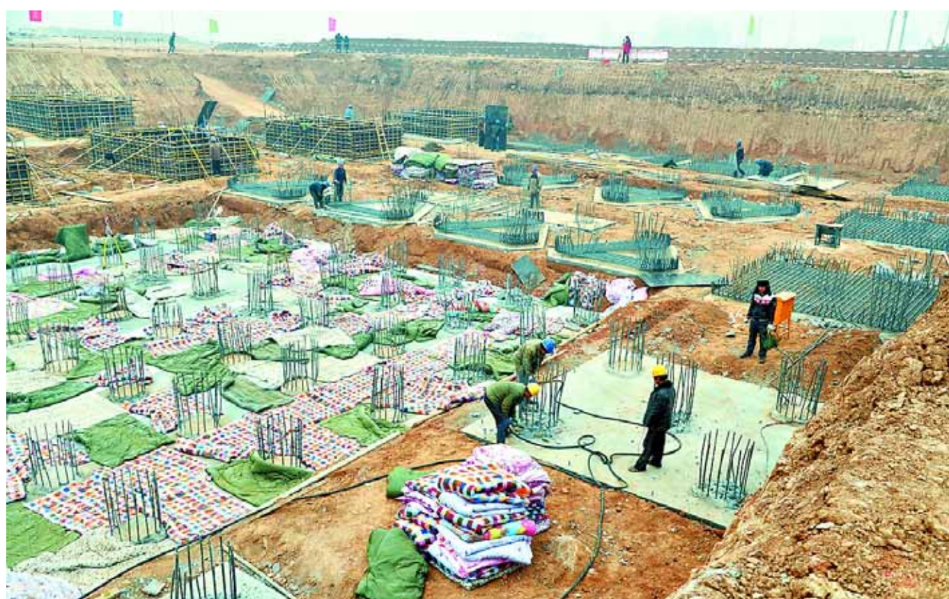
冬季施工混凝土不易凝固，鹤淇电厂主厂房建设
