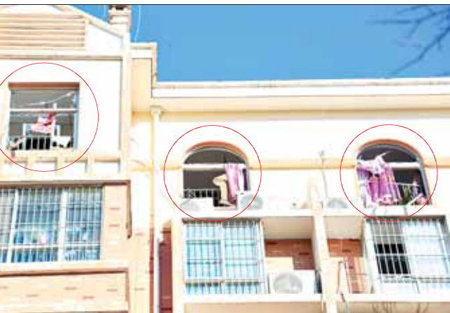
爆炸产生的气流导致居民家的塑钢窗户整个脱落(图中红圈处)。
