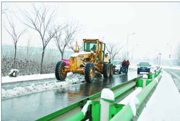
近日我市持续降雪,路面结冰,严重影响了交通安全。为确保全市干线公路的安全畅通,2月5日7时起,市公路局对全市境内干线公路的坡道、桥面等重点路段进行除雪防滑处理。截至目前,共紧急调拨养路工360余人,投入平地机、车辆等机械设备32台辆,撒铺盐32吨用于融雪防滑。 本报记者 陈海寅 摄
