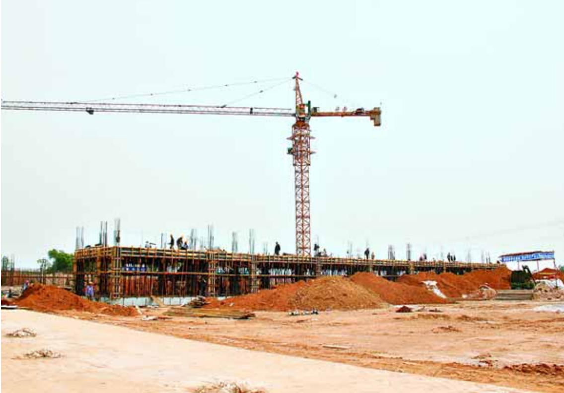
总投资1.5亿元的小樱桃动漫集团鹤壁教育基地项目目前已完成投资3000万元,该项目集学前教育、小学教育和社会职业培训为一体。图为正在施工建设的教学楼。
