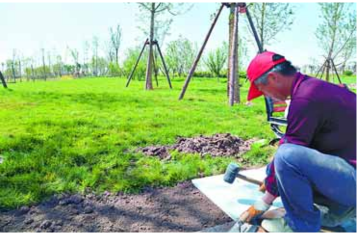
5月26日,记者在淇奥翠境项目施工现场看到,工人们正在铺设收边石板,做工程的收尾工作。 本报记者 李国庆 摄
