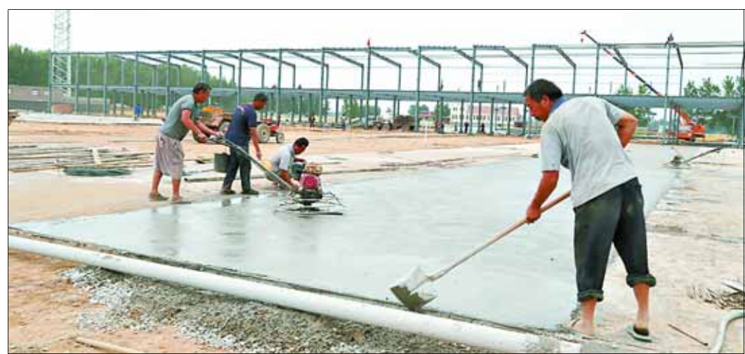
图为正在建设的鹤浚大道改建工程临时安置点。该安置点建成后可安置商户300户。
