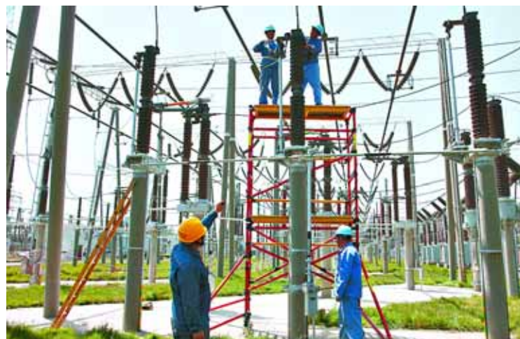
供电公司工作人员在检修隔离开关。
