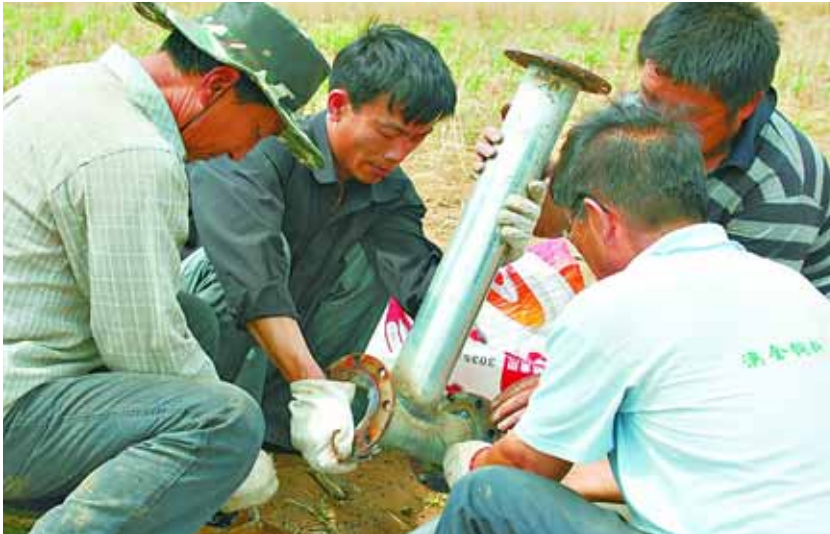
鹤壁集镇大岗寨村由于水管等灌溉设施老化,加上离水源较远,导致村中100余亩田地无法灌溉。针对这一问题,该村“两委”筹措资金7万余元,铺设长1500米的农田灌溉管道。目前已铺设管道700余米,预计半月左右可铺成。图为村干部及义工在铺设管道。 张付霞 摄
