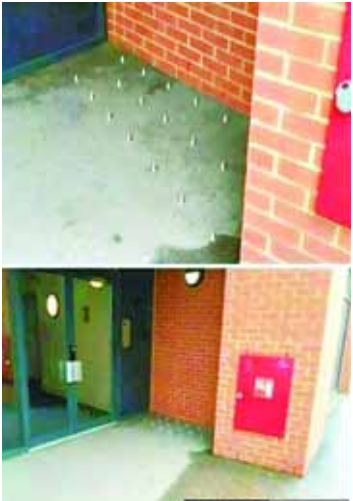
公寓入口处安装的栓钉。
